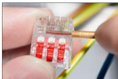
Avisoleringslengde 10 mm er markert på koblingsklemmen.
